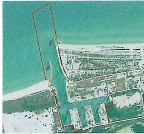
Figura 28 Obras de protección del Recinto Portuario de Sisal
