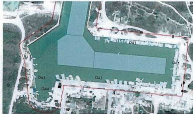
Figura 44 Obras de atraque del Recinto Portuario El Cuyo.
